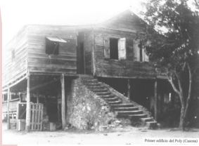
Primer edificio del Poly (Cramer)
